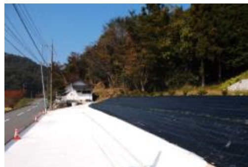
（施工後） 駐車場は舗装され法面には、サツキ・芝桜・花桃など植えました
